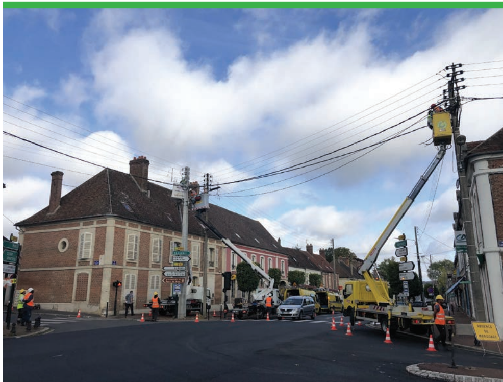
Travaux de renforcement de basse tension à Noailles.
