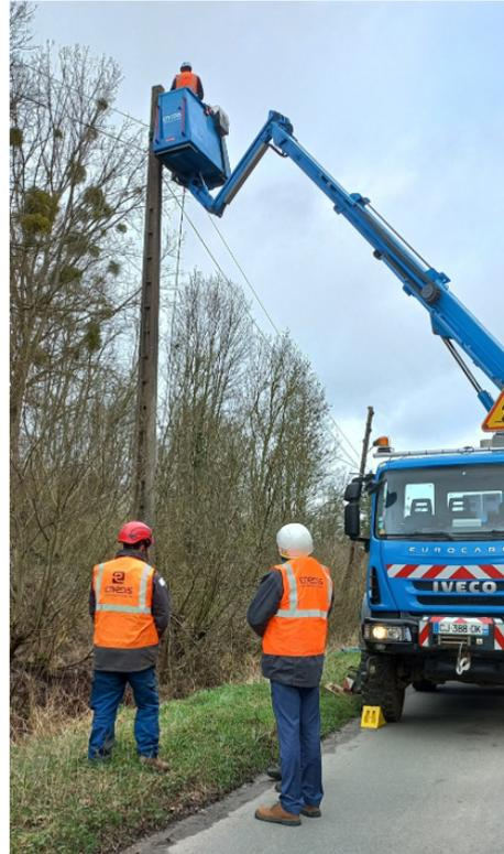
Chantier réalisé à Rousseloy (60) suite à la chute d'un arbre sur une ligne HTA. Les travaux ont consisté à l'élagage des arbres situés à proximité, au remplacement d'un armement et à la réparation des conducteurs. Près de 600 clients étaient impactés par cette coupure.
