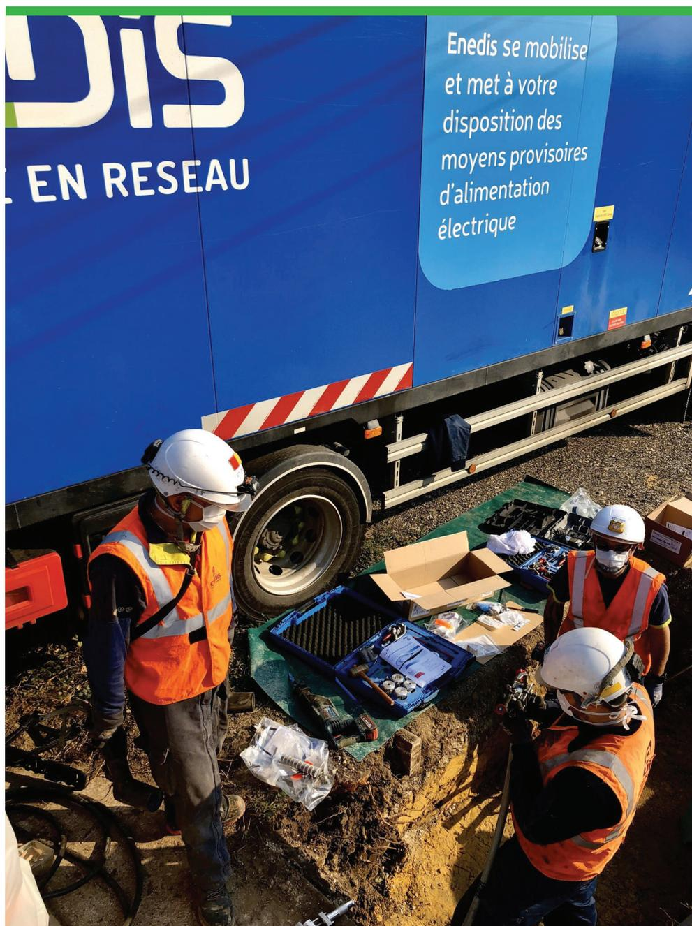
Intervention de dépannage sur le réseau HTA souterrain à Berneuil sur Aisne
