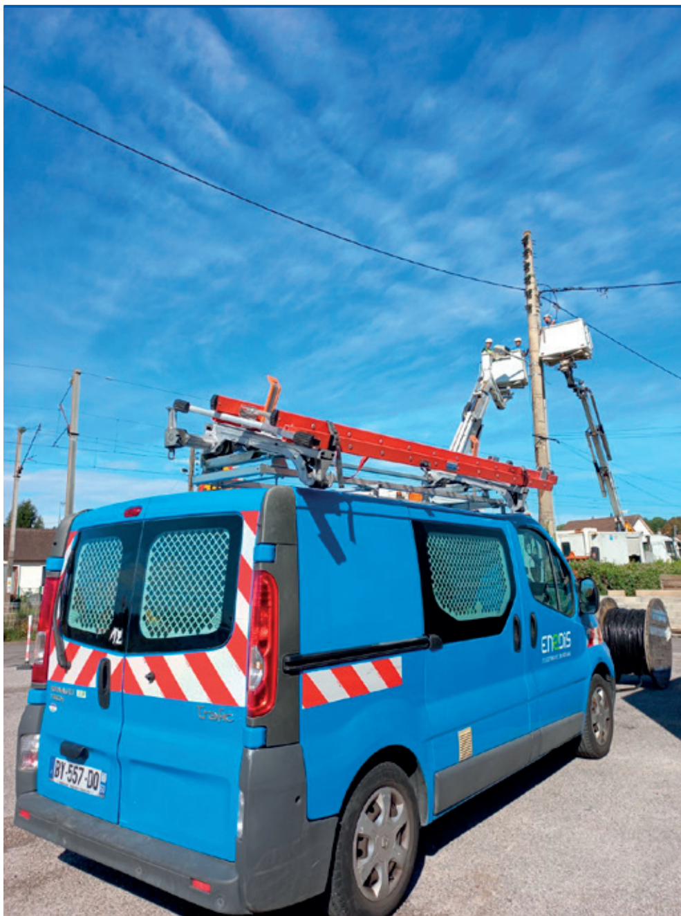
Le 6 septembre, nos équipes réalisent une opération de maintenance en lien avec nos prestataires en remplaçant un support béton et le réseau BT associé sur la commune de CAUFFRY (rue Carrette et Rue des vieilles écoles).
