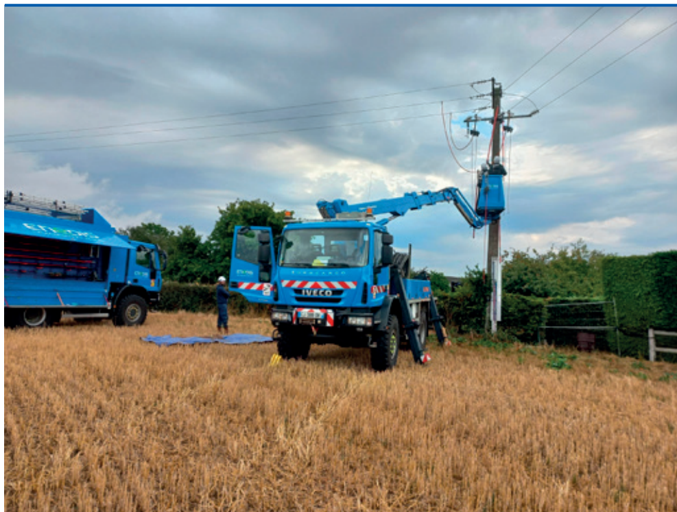
Nos équipes des Travaux Sous Tension (TST) HTA posent un Interrupteur Sectionneur Provisoire (ISP) le 2 septembre sur la commune FLAVACOURT.
