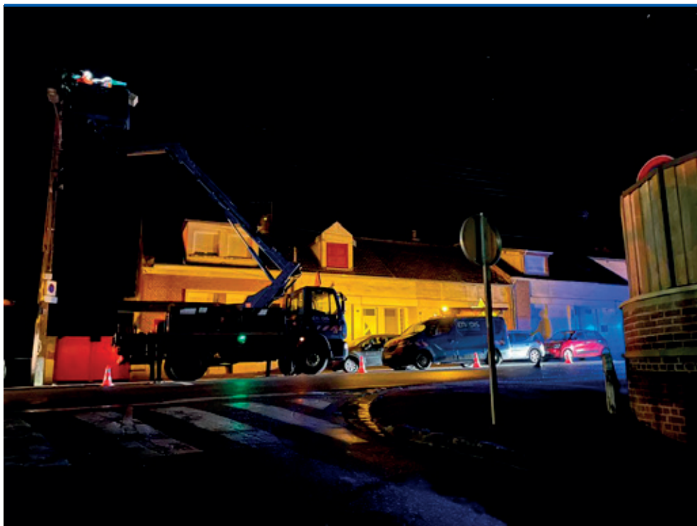
Le 22 février, nos équipes sont à pied d'oeuvre, de nuit, lors d'une opération de dépannage du réseau BT avenue Frère à BRETEUIL.
