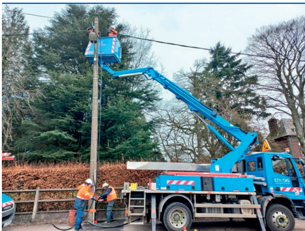
Le 17 mars, nos équipes réalisent un changement du point d'ouverture sur le réseau BT afin d'assurer l'équilibrage de ce réseau et ainsi une alimentation de qualité, suite à une opération de raccordement collectif de 18 nouveaux logements sur la commune de FEUQUIERES.
